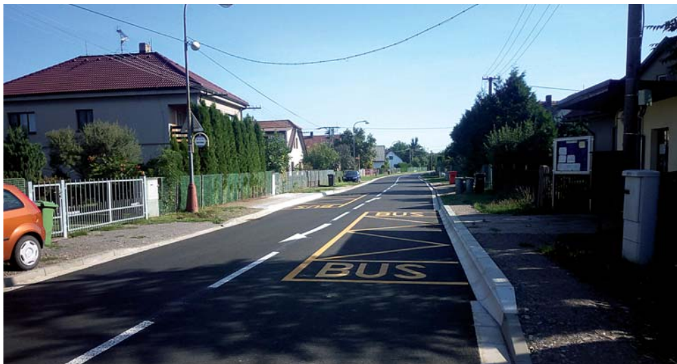
Rekonstrukce silnice III/34019 a III/34020 Stolany
